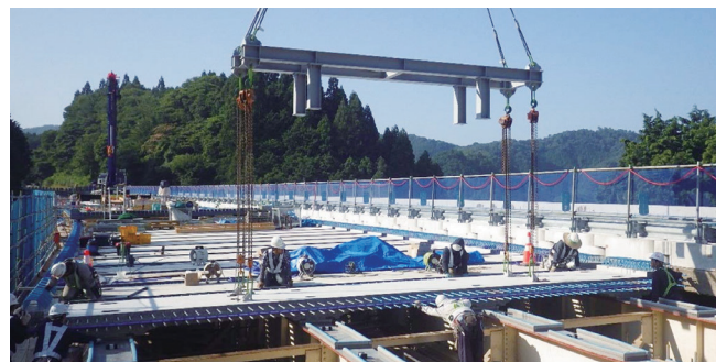
プレストレストコンクリート床版架設
