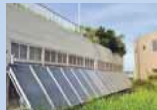
太陽光パネルの設置
