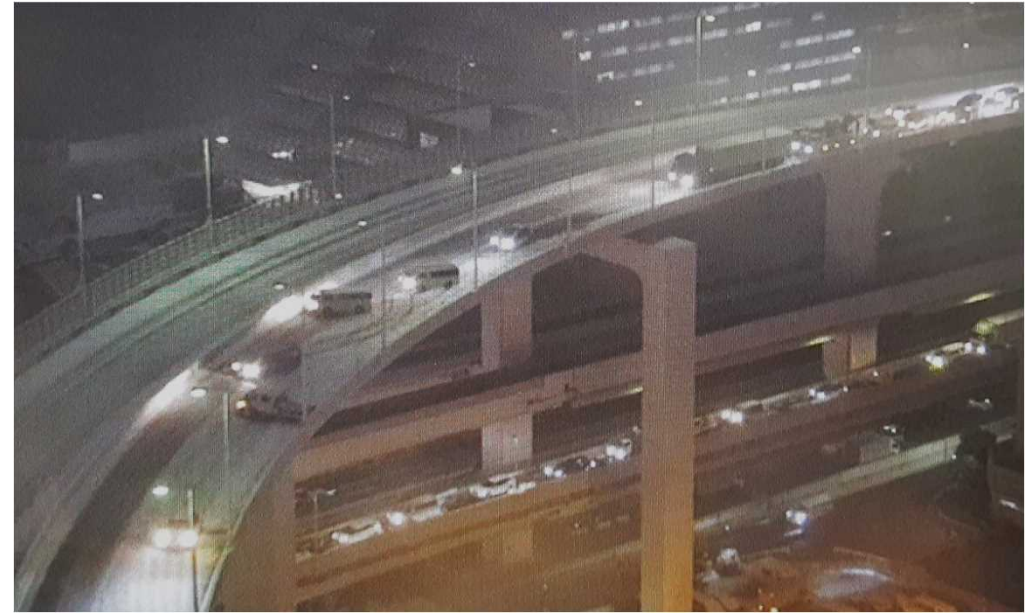
車両の滞留 ＜首都高速道路 台場線＞
