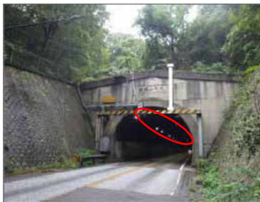
トンネル内の配線更新
